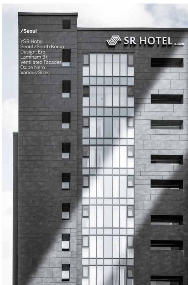
Laminam Spa производит и поставляет керамогранитные плиты для применения в системах вентилируемых /стоечно-ригельных фасадов. Работы должны осуществляться специализированными компаниями, которые занимаются проектированием и установкой. Управление проектом (Project Management) Laminam SpA обеспечивает техническую помощь и значения устойчивости плит к ветровым нагрузкам для правильного определения размеров и установки.
